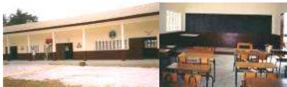
Ecole Pilote Emery Patrice LUMUMBA
